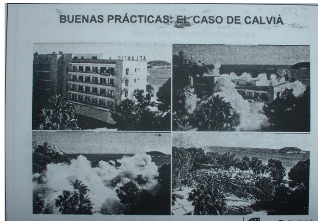
Demolición del Hotel Atlantic
